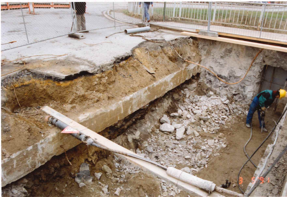
Démolition mur garde grève Culée RIVE GAUCHE. La Poutre visible est la liaison des 2 murs en retour.
