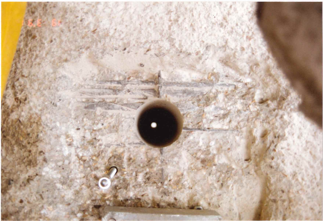
Précontrainte transversale Perçage du Bloc d'about \phi 110
