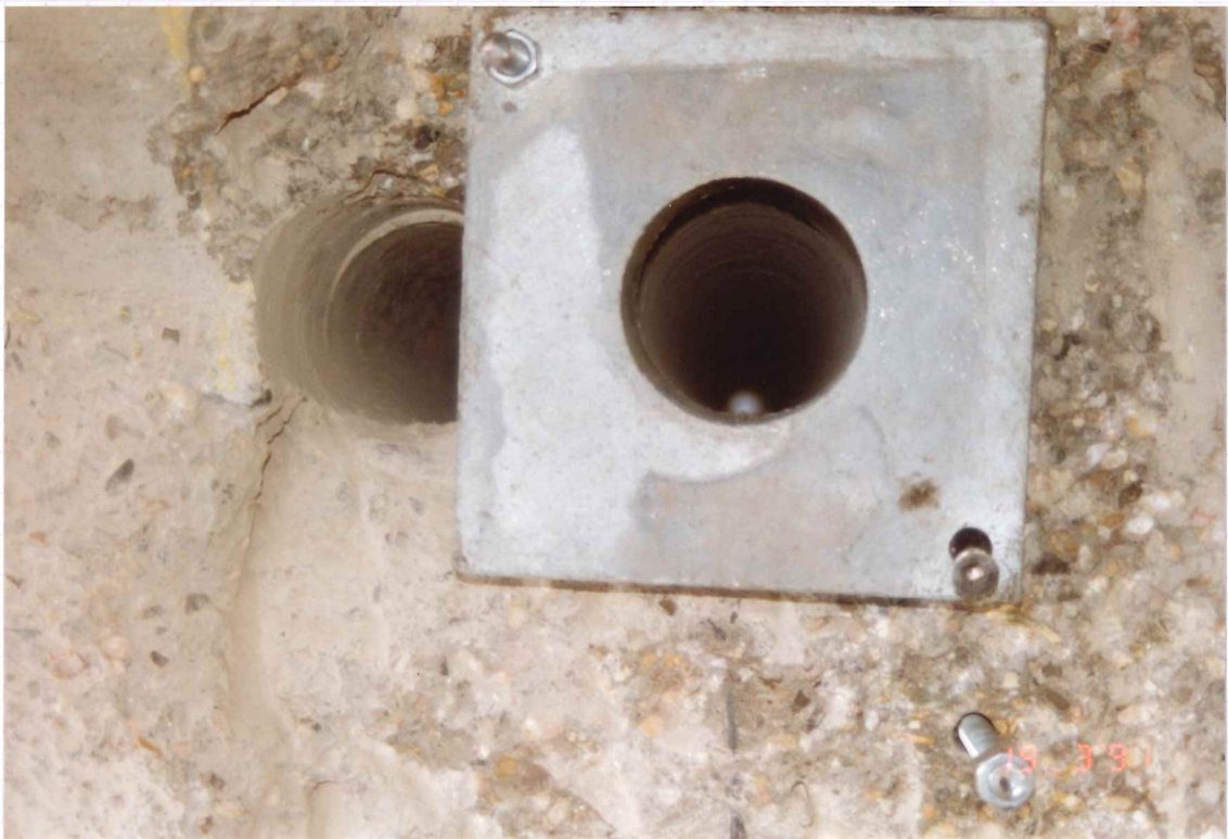
Positionnement de la plaque d'ouillage. Précontrainte transversale.
