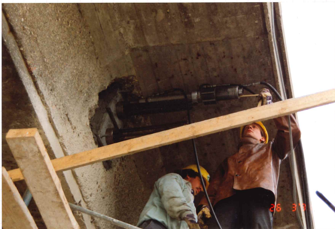
Mise en position de la Tive gauche Precontrainte Casseverte
