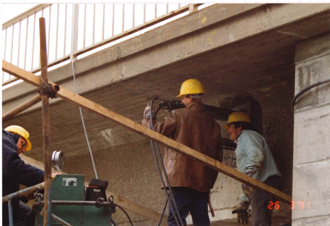
Vérification de l'allongement lors de la mise en Exécution.
