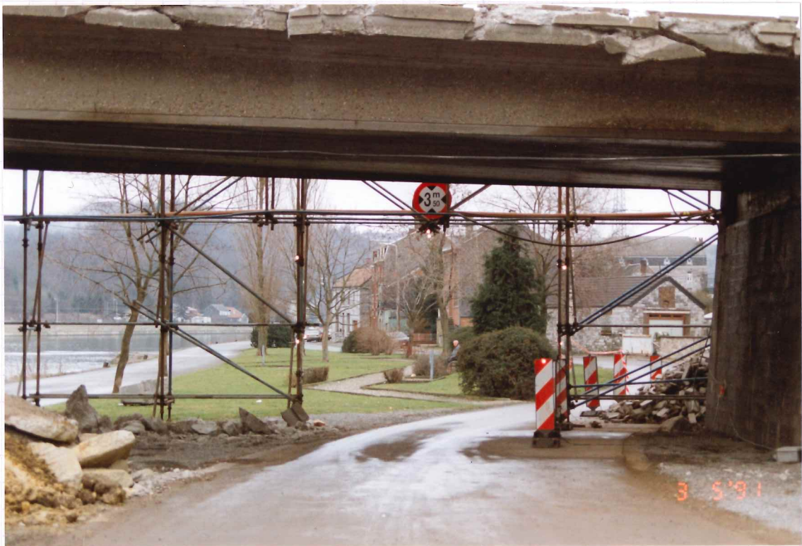
Sous la Cravée d'approche. H limitée 3m et L limitée 3m
