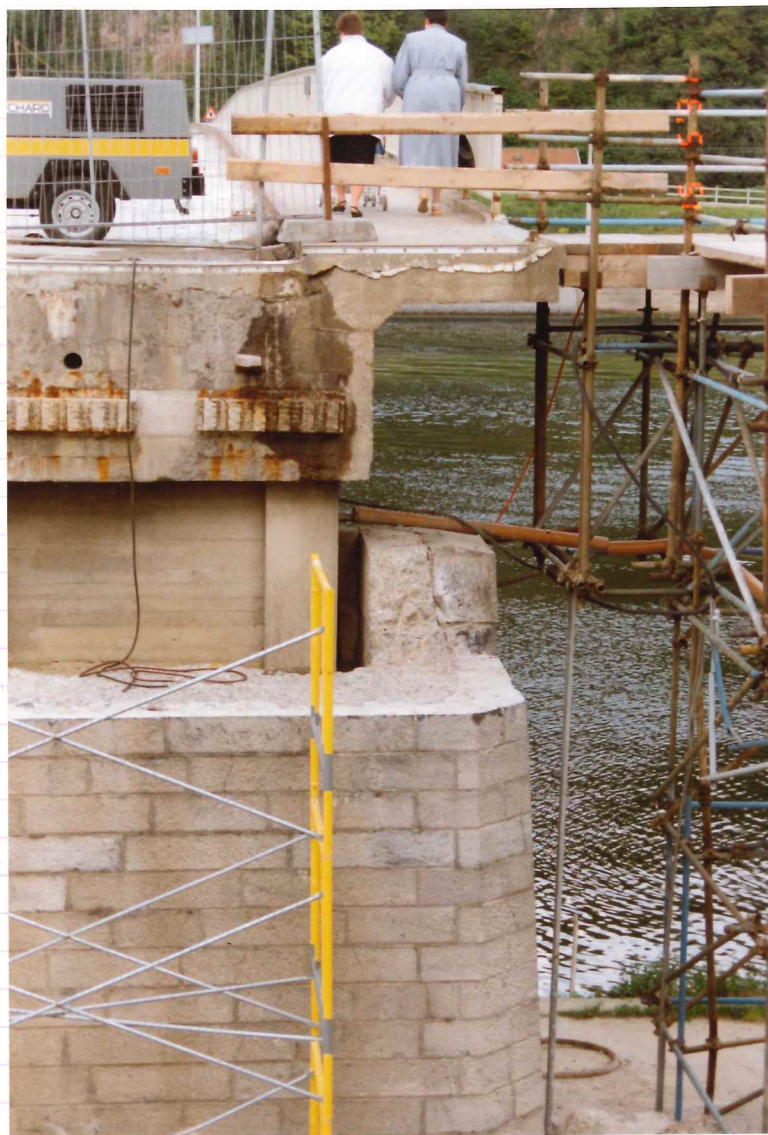
Abaissement du béton de remplissage de la pile Trouwelle
