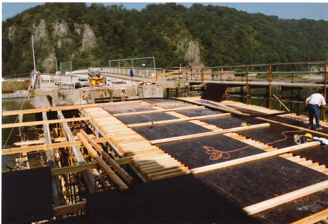
Coffrage de la travée d'approche Rive droite.
