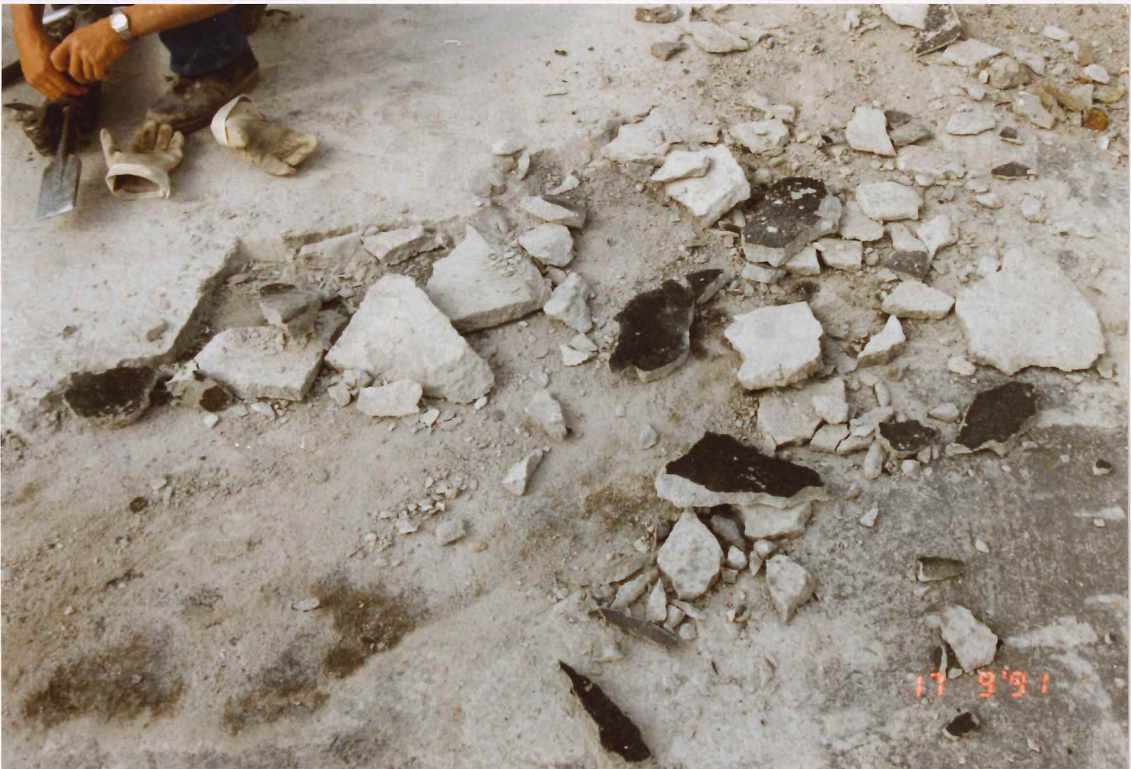
Séclage des restes de chape au mortier le trouvant sur le Bit.
