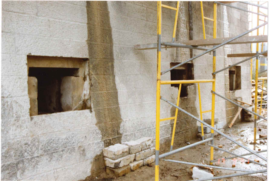
Brous dans le pied de la pile nouvelle. (Extrait de pose pour explosifs).
