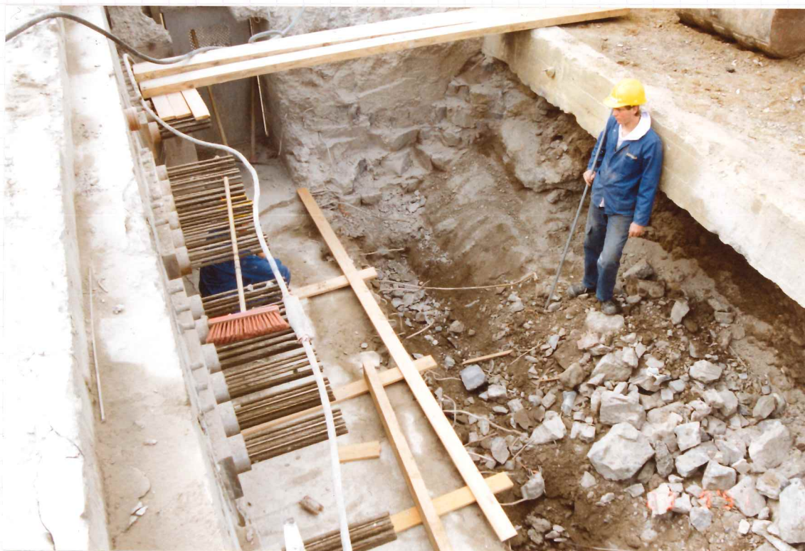
Culée rive gauche. Soudages manuel au bord de l'ancien mur garde/voie.
