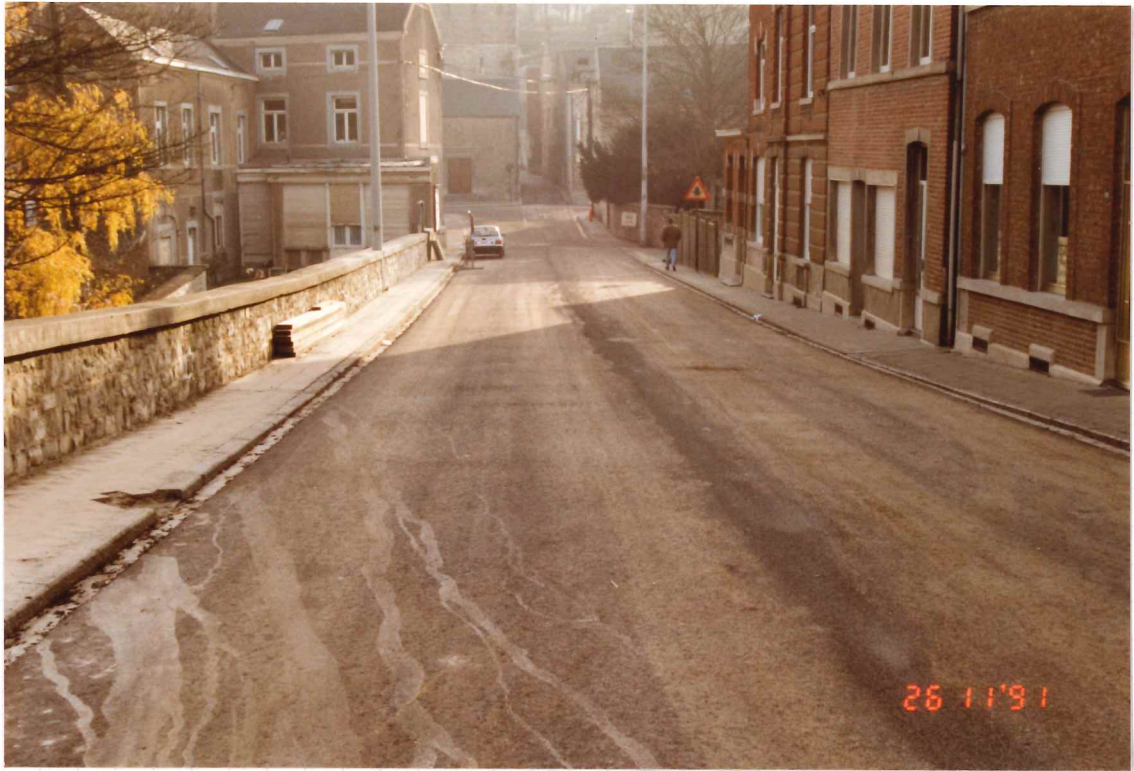
Vue du revêtement aux abords du Pont.
