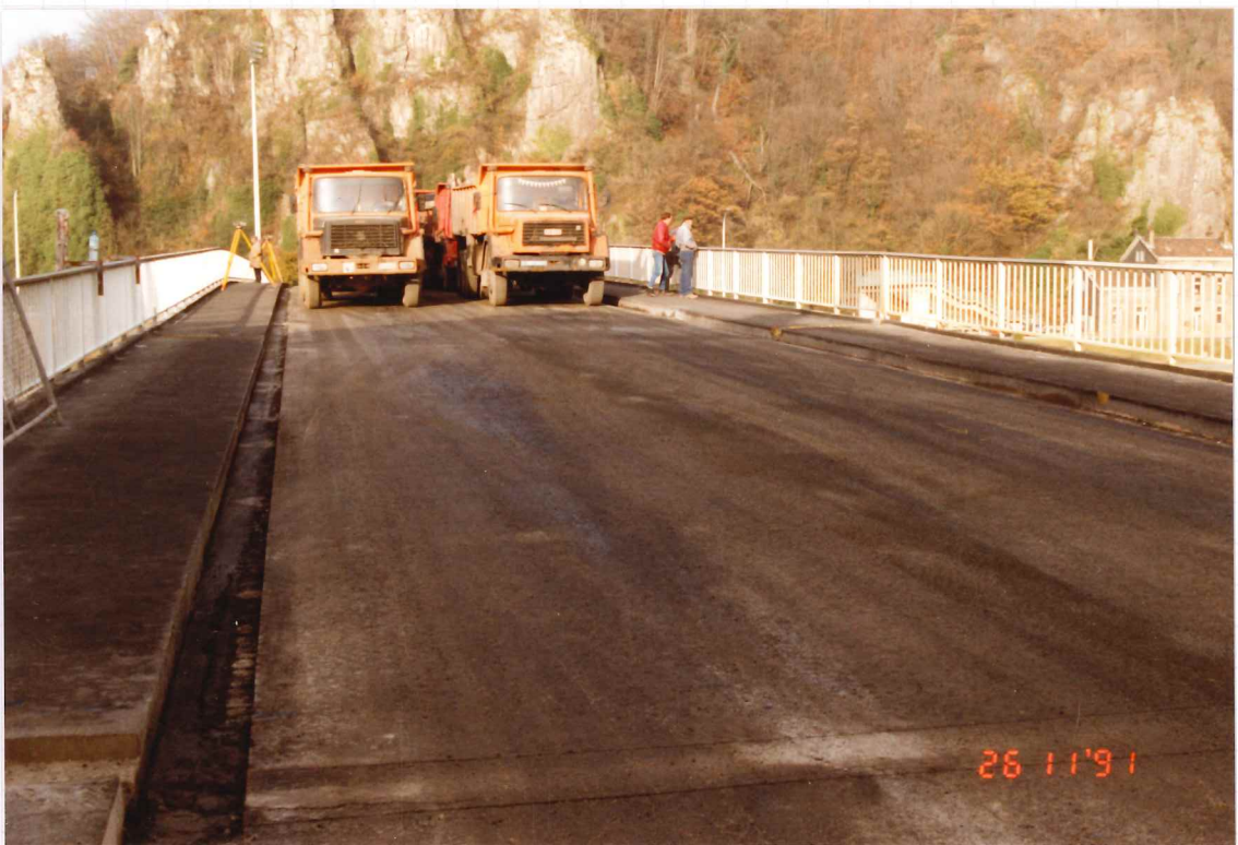
Essai de charge du Pont. voir planche.
